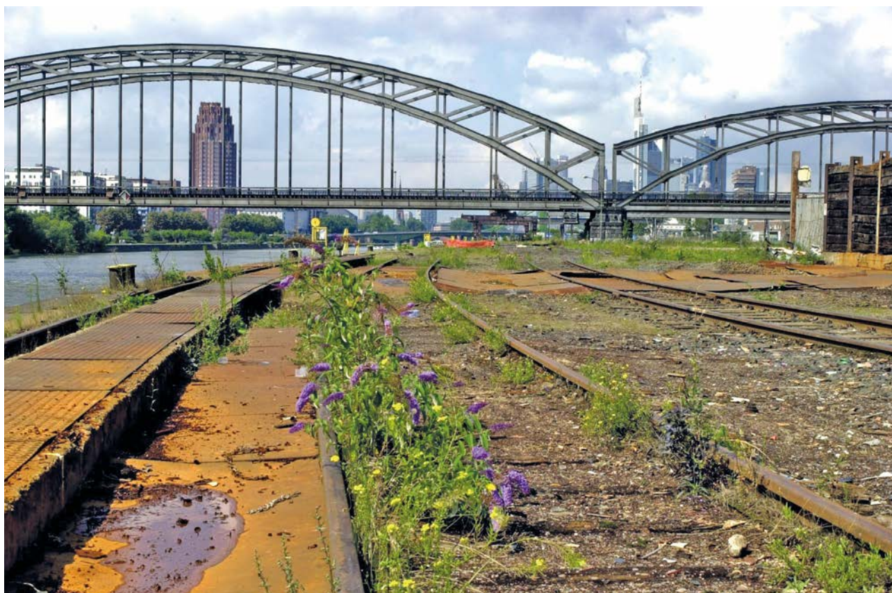
Industriebrache östlich der Deutschherrnbrücke, heute „Hafenpark“ mit Skateranlagen; auf der westlichen Seite befindet sich die ehemalige „Weseler Werft“ mit dem alljährlichen Sommerprogramm, 5. August 2002 (Fotosammlung Georg Kumpfmüller, ISG FFM Best. S7Ku Nr 2401)
