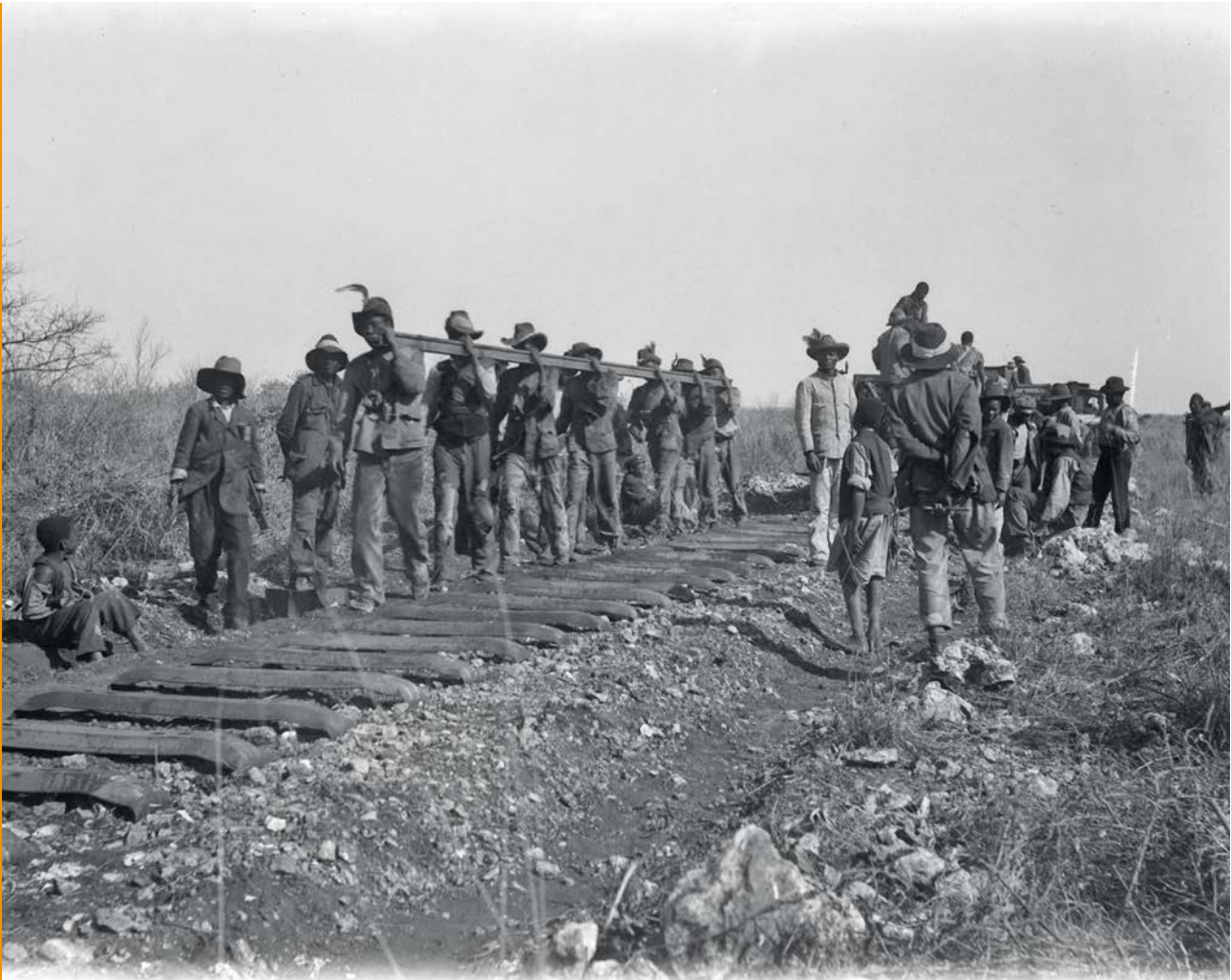
Otavi - Bahnbau bei Okaputa, Vortreckkolonne von Herero-Arbeitern, aufgenommen in Südwestafrika 1905 (UB JCS Bildbest. DKG Nr. 013-2082a-04)
