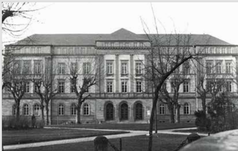
Darmstadt, Landgericht / Südfront nach Abschluss des Wiederaufbaus (HStAD R 4 Nr. 22053)
